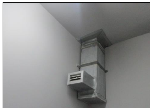
รูปที่ 28 พัดลมดูดอากาศ ภายในห้องพักขยะ
