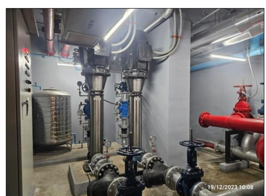
รูปที่ ๑ ถังสำรองน้ำใช้ ฝาลัง วาล์วเปิดน้ำประปา สภาพน้ำในถัง และปั๊มสูบน้ำดับเพลิง
